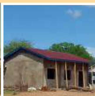
Construcción aulario en la escuela de Ciatungu (Tharaka) Diputación de Córdoba
