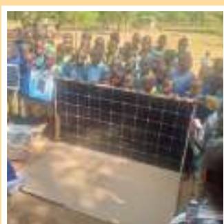
Instalación de panel solar en la escuela de Gakombe (Tharaka) Ayuntamiento de Zumárraga
